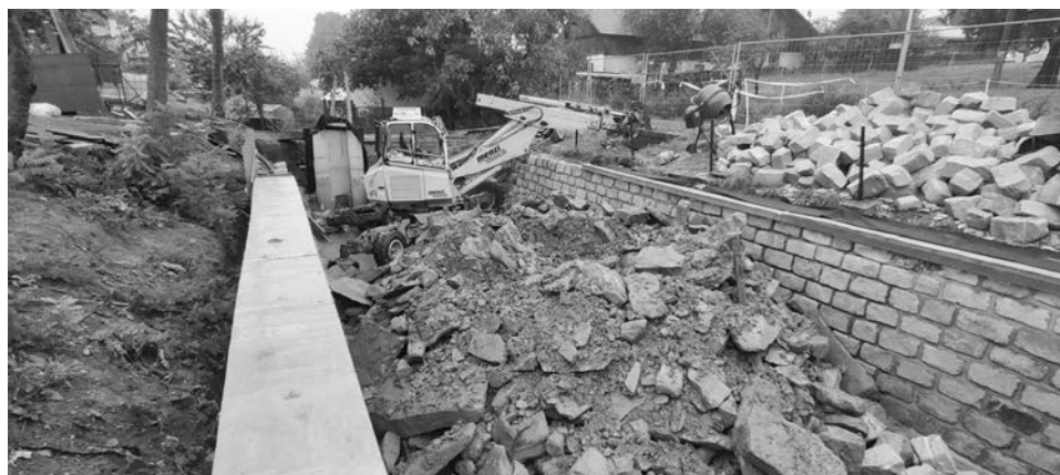
Záběr z průběhu rekonstrukčních prací na vodní nádrži ve Svinné
